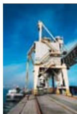
Chargement de vrac automatisé
